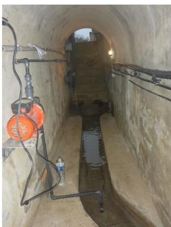
*Fin de la galerie technique avec son caniveau de drainage des eaux brutes. L'escalier de sortie est visible au fond*
